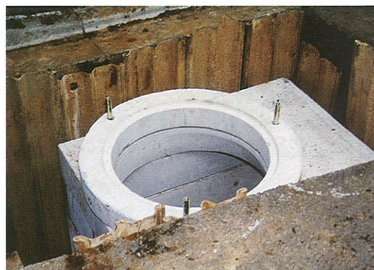
調整ブロックの据付け
