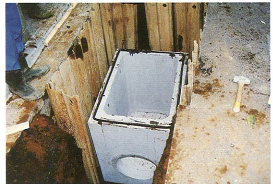
管取付壁の据付け
