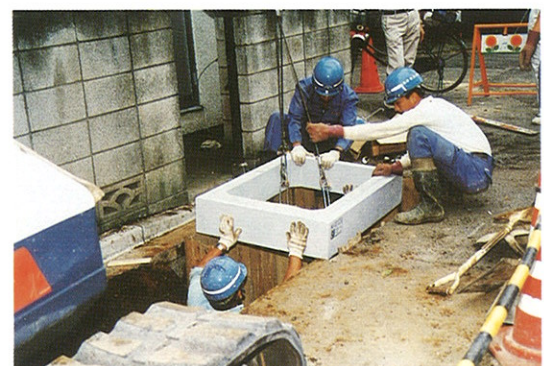
直壁の据付け
