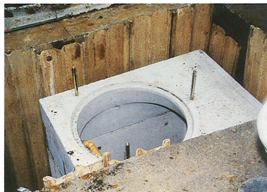
床版の据付け（継ぎボルト取付）
