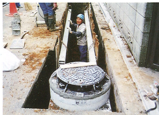
マンホール鉄枠の取付け
